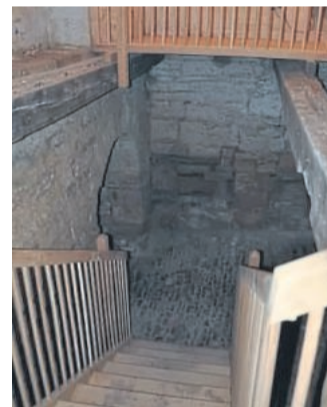
Das neue Treppenhaus im Flechtdorfer Konventsgebäude.
